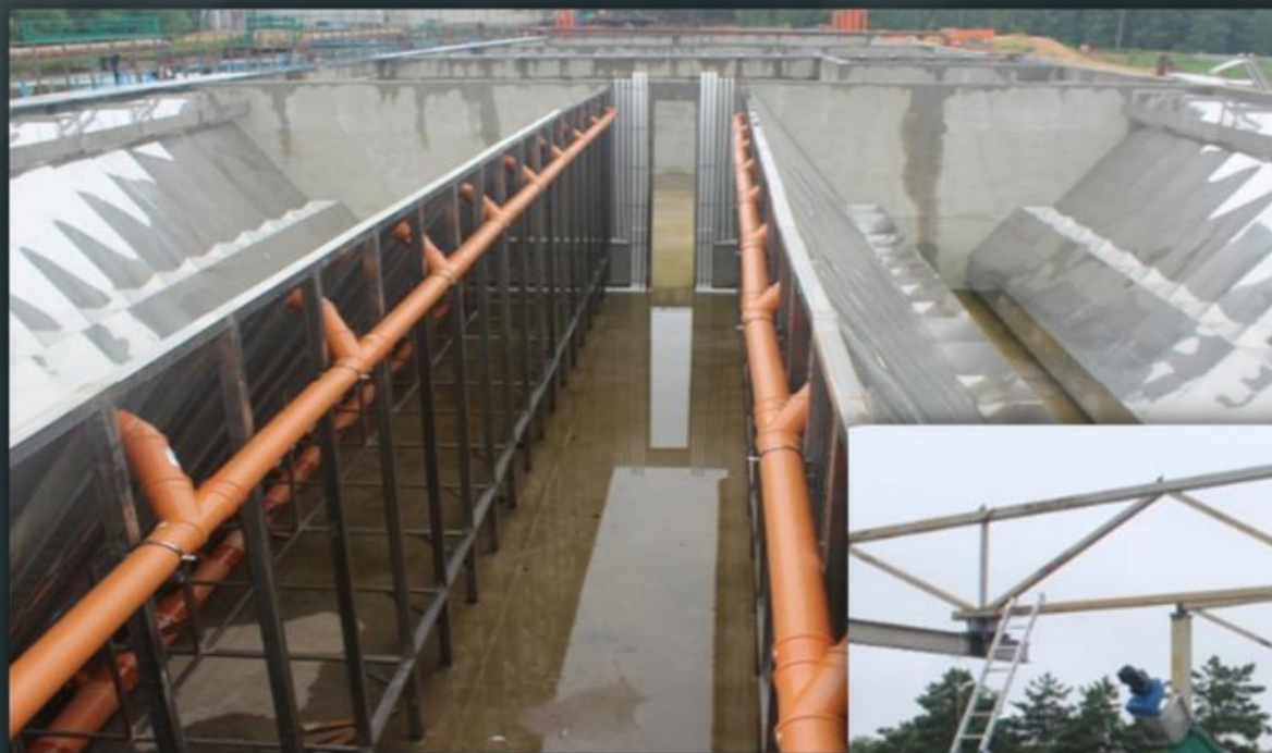
Реконструкция БОС р.п. Досчатое
